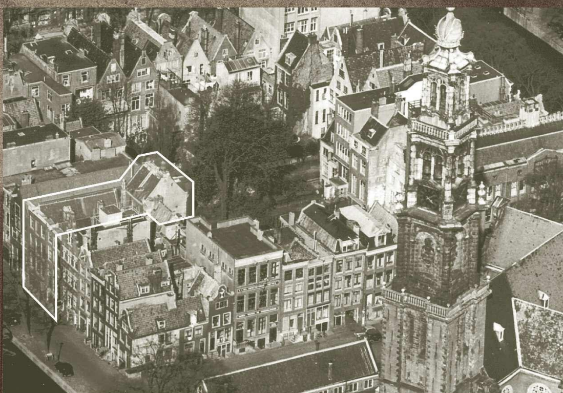
El edificio de oficinas a orillas del canal Prinsengracht. Al fondo, la «casa de atrás» que albergaba el escondite.
